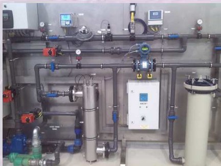
УФ-дезинфекция технической воды
