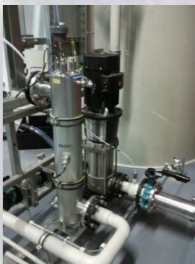
УФ-дезинфекция технологической воды
