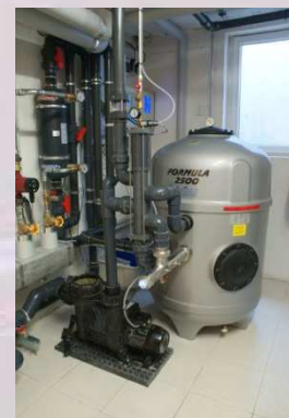
УФ-дезинфекция воды в плавательном бассейне
