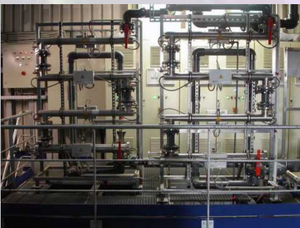
УФ-обработка воды для снижения химического потребления кислорода (ХПК) в доке Гамбурга
