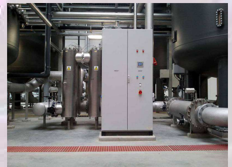
УФ-обработка при водоподготовке больших объемов воды Q_{\text{max}} 2 \times 500 \text{ м}^3/\text{ч} в Антверпене
