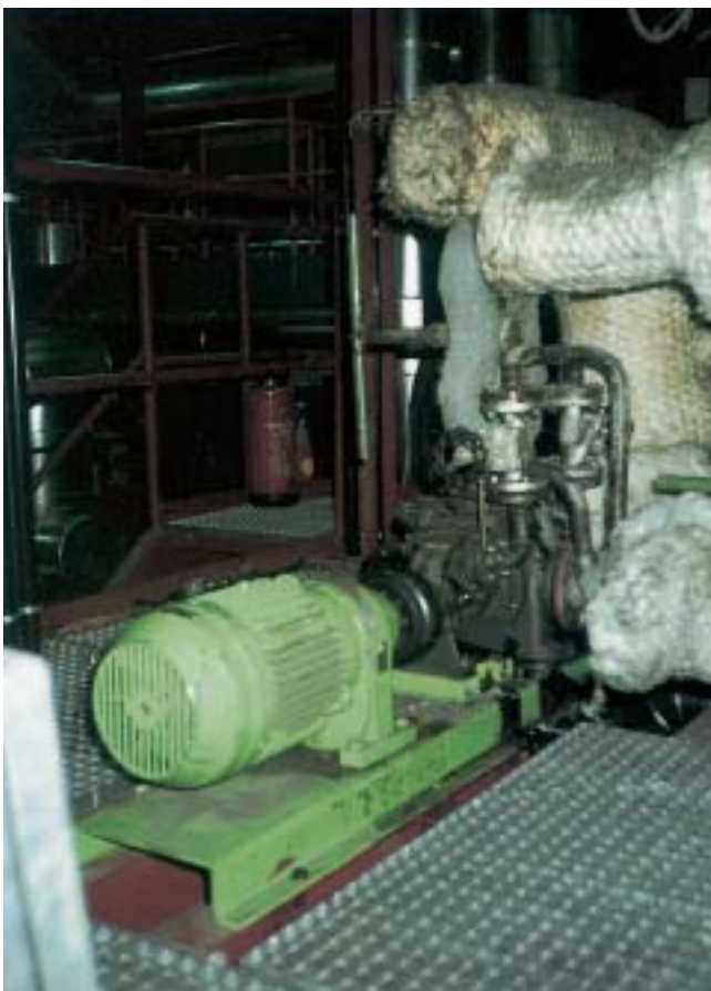
V60-2 SPHTRR pump handling pitch in a graphite electrode plant. Pompe V60-2 SPHTRR pour poix dans un équipement pour la production d'électrodes en graphite.
