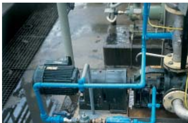
V60-2 SP1G pump in a detergent production plant. Pompe V60-2 SP1G dans un équipement pour la production de détergents.
